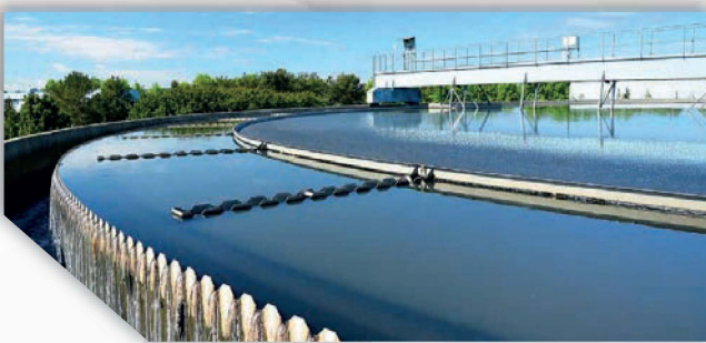
Water Treatment Tratamiento de Aguas
